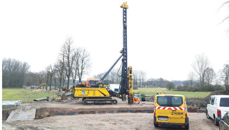
Bauarbeiten an der K 42
