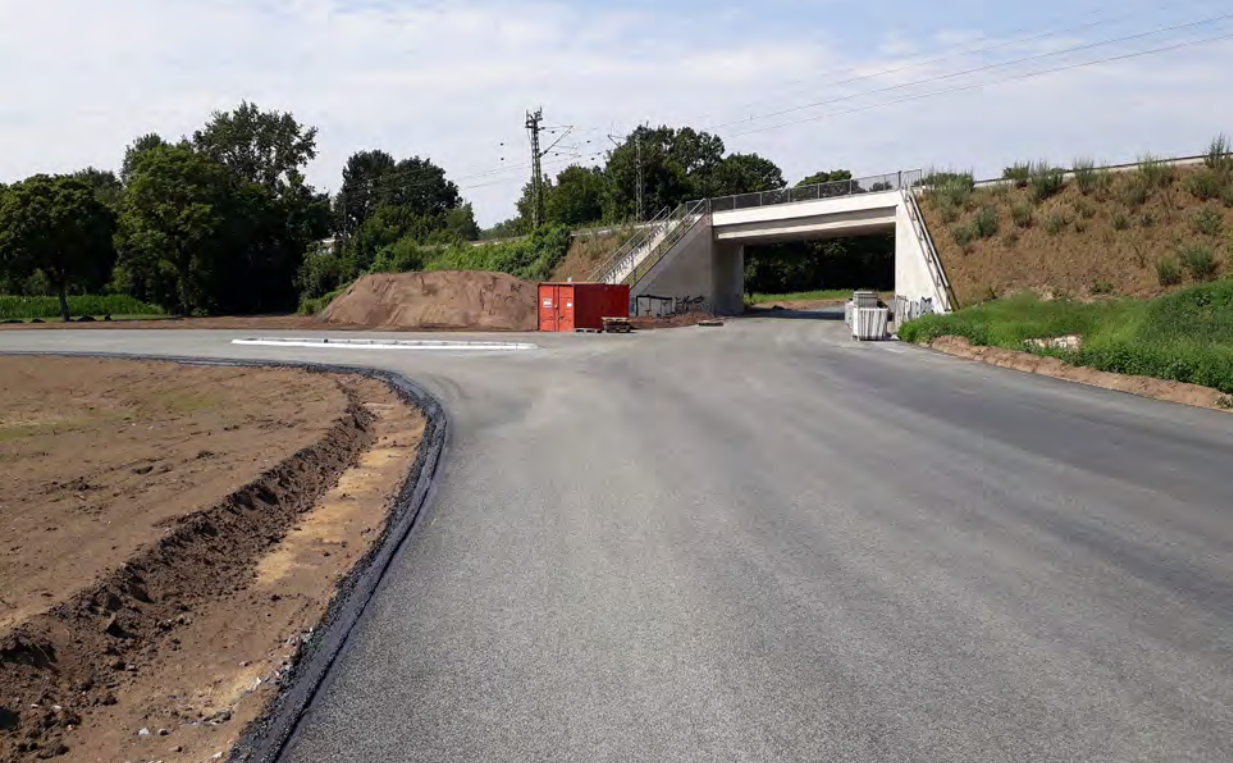
K 17 n, südliche Entlastungsstraße in Dülmen
