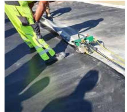
**OFA Südrand – Kunststoffdichtungsbahn schweißen**
