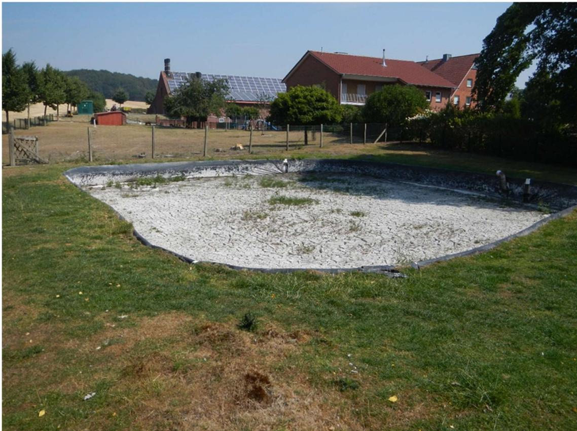
*Teich 2 mit starken Trocknungsrissen, Uferbereiche mit Folie verkleidet*
