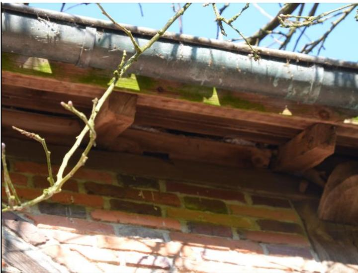
Abbildung 8: Spalten unterhalb der Regenrinne, Zugänge zum Dachboden
