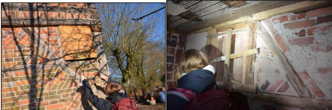
Abbildung 5: Mit Brettern verschlossene Fensteröffnung, außen (links) und innen (rechts)
