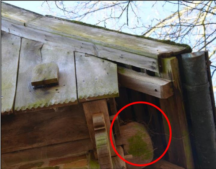
Abbildung 7: Balkenvorsprung mit Vogelnest
