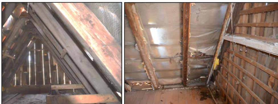
Abbildung 6: Dachboden mit Spalten im Dach und der Verschalung
