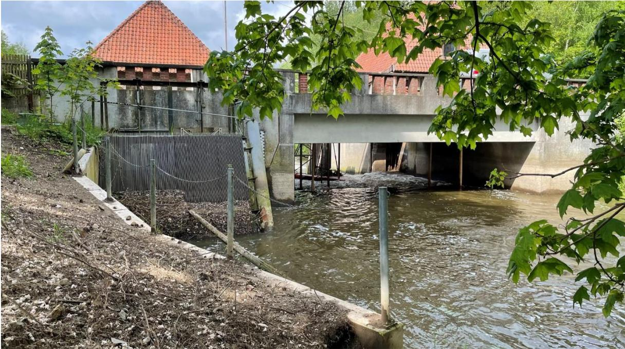
Abb. 2: Bestehende Vertikalrechenanlage (im Bild links der Uferbereich für die neue Rechenanlage)
