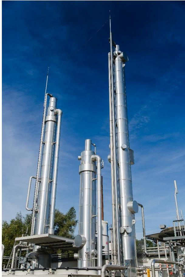
Abbildung 48. Aufbereitungsanlage für das erzeugte Biogas
