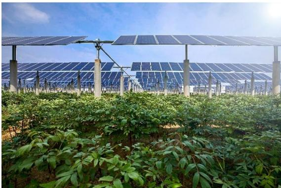
Abbildung 5: Foto einer aufgeständerten Agri-PV-Anlage, die neben der Stromerzeugung eine landwirtschaftliche Nutzung ermöglicht (Quelle: ENWELO GmbH & Co. KG; @jeson – stock.adobe.com)
