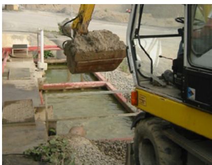
Leeren des Recyclingtanks mit einem Bagger
