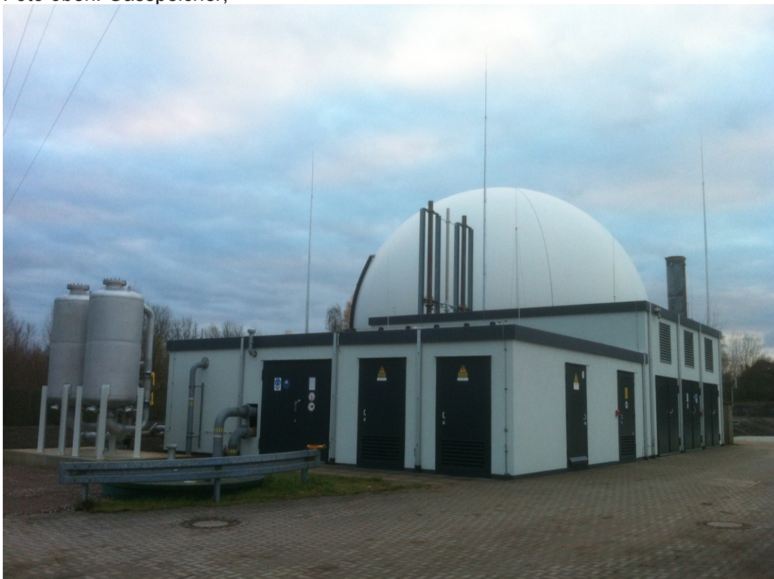
Foto oben: BHKW
