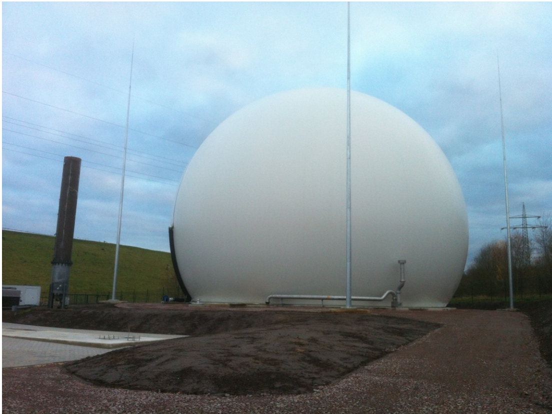
Foto oben: Gasspeicher,
