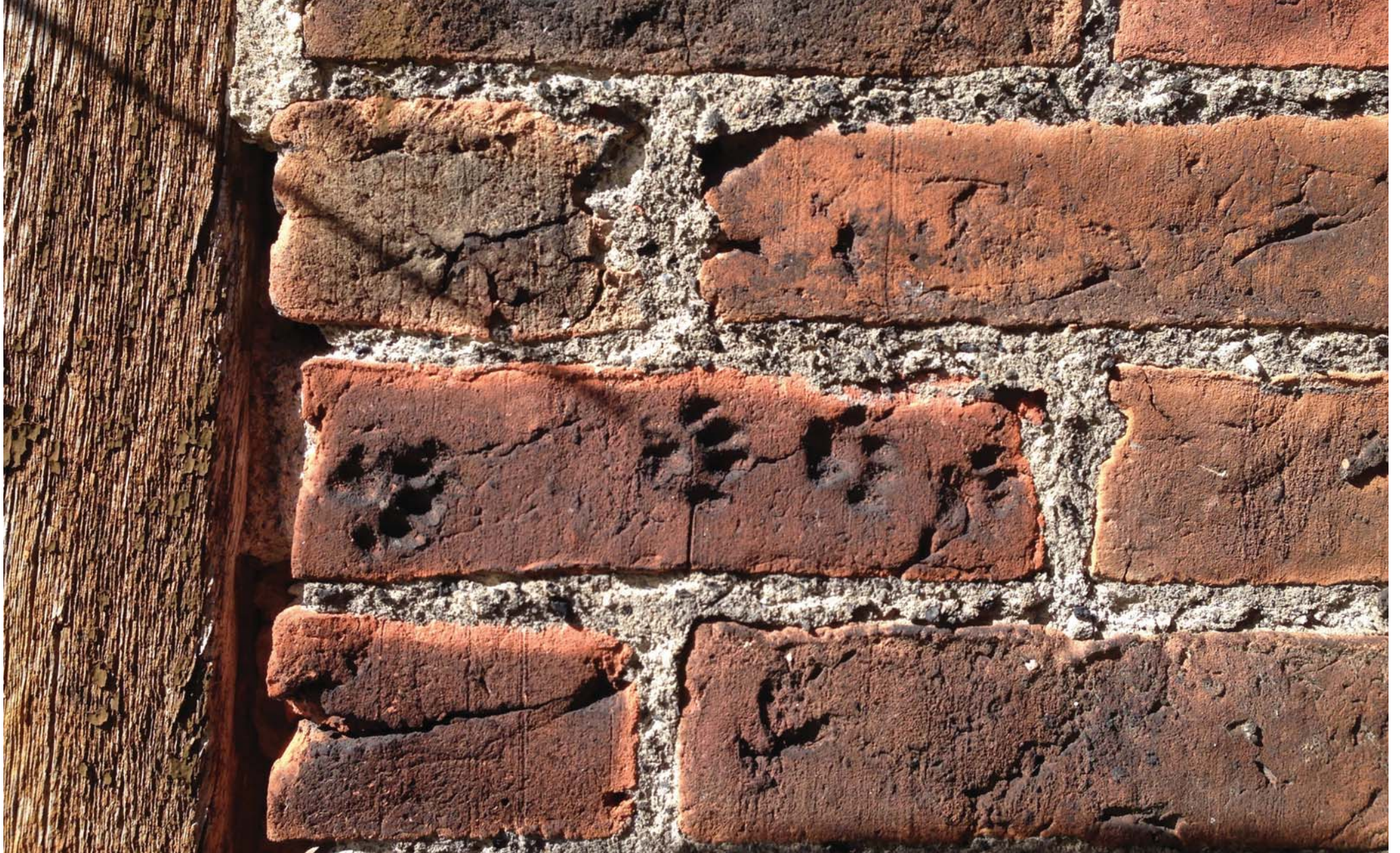
Spurensuche bei der Fassadensanierung
