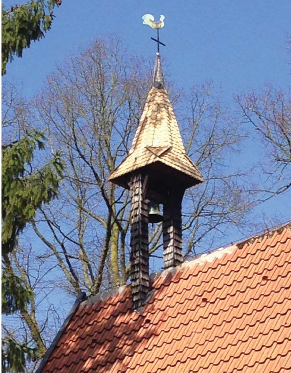
Glockenturm, Sanierung Turmhaube
