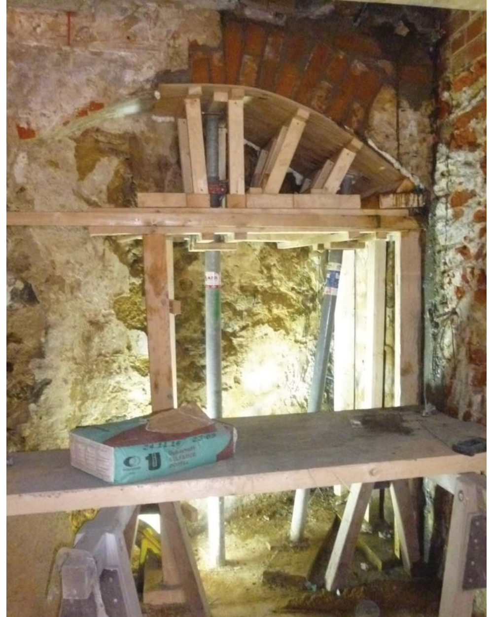
Sockelgeschoss, Wiederentdeckung und Herstellung eines Bogens
