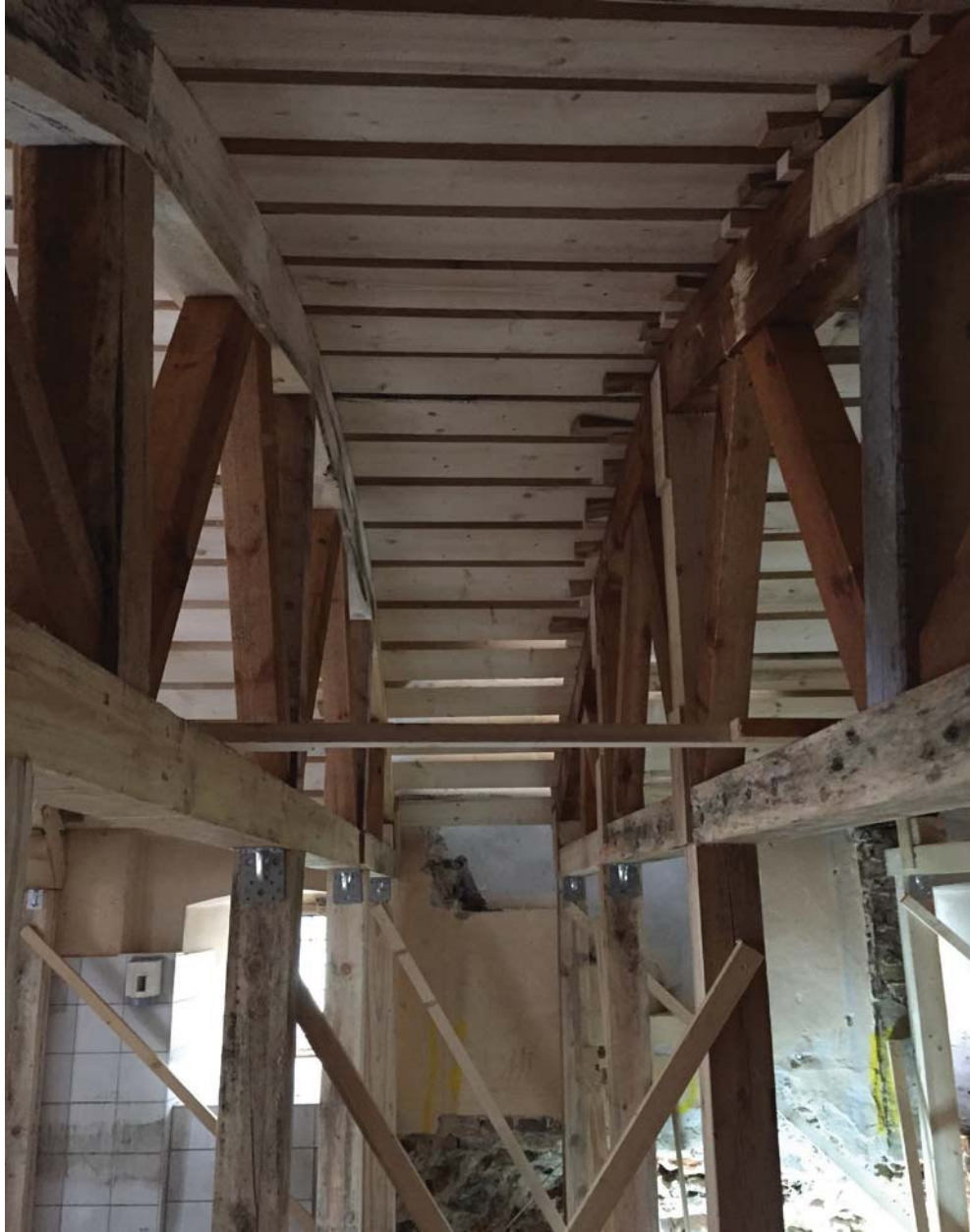
Sockelgeschoss, Erschließung mit Gewölbeabstützung unter der neuen Gewölbeöffnung
