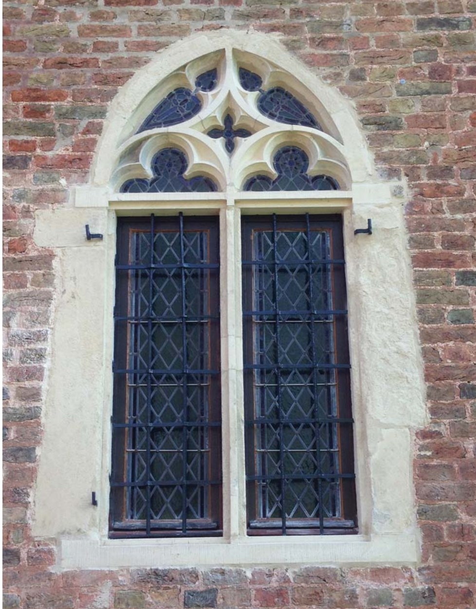
Sanierung Sandsteingewände und Fenster einschl. Bleiverglasung
