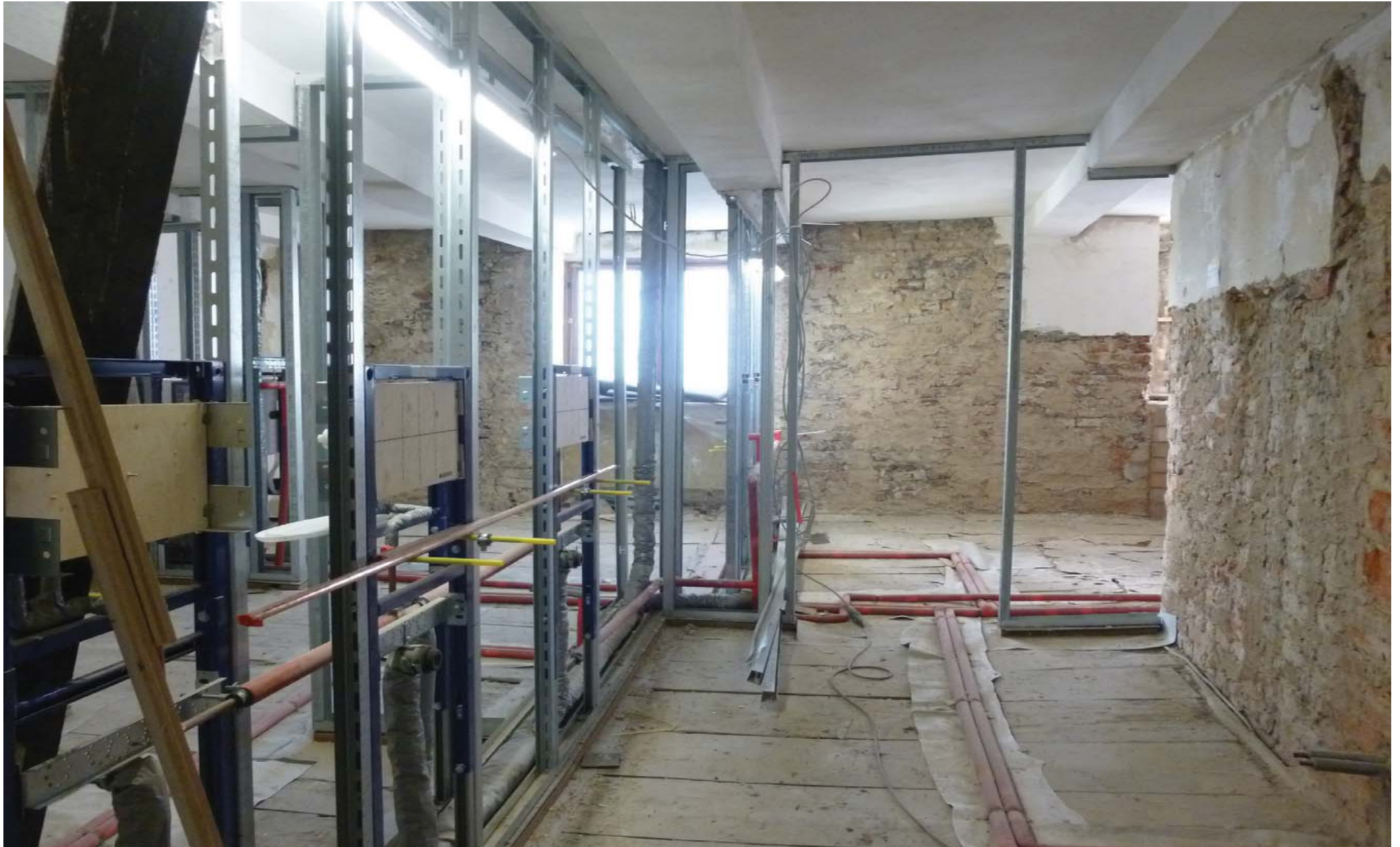
Obergeschoss, Haustechnik, WC-Bereich
