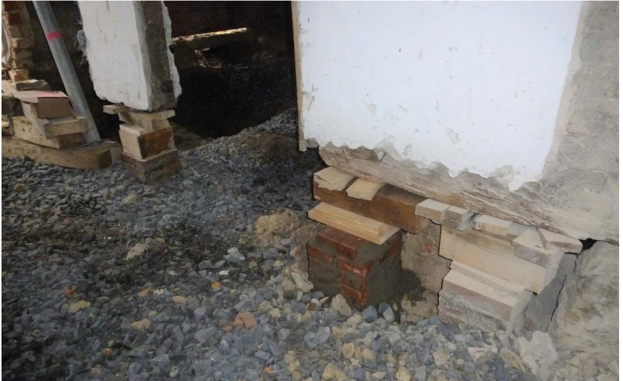
Museumsshop nach den Rückbauarbeiten, Lagesicherung Bestandswände
