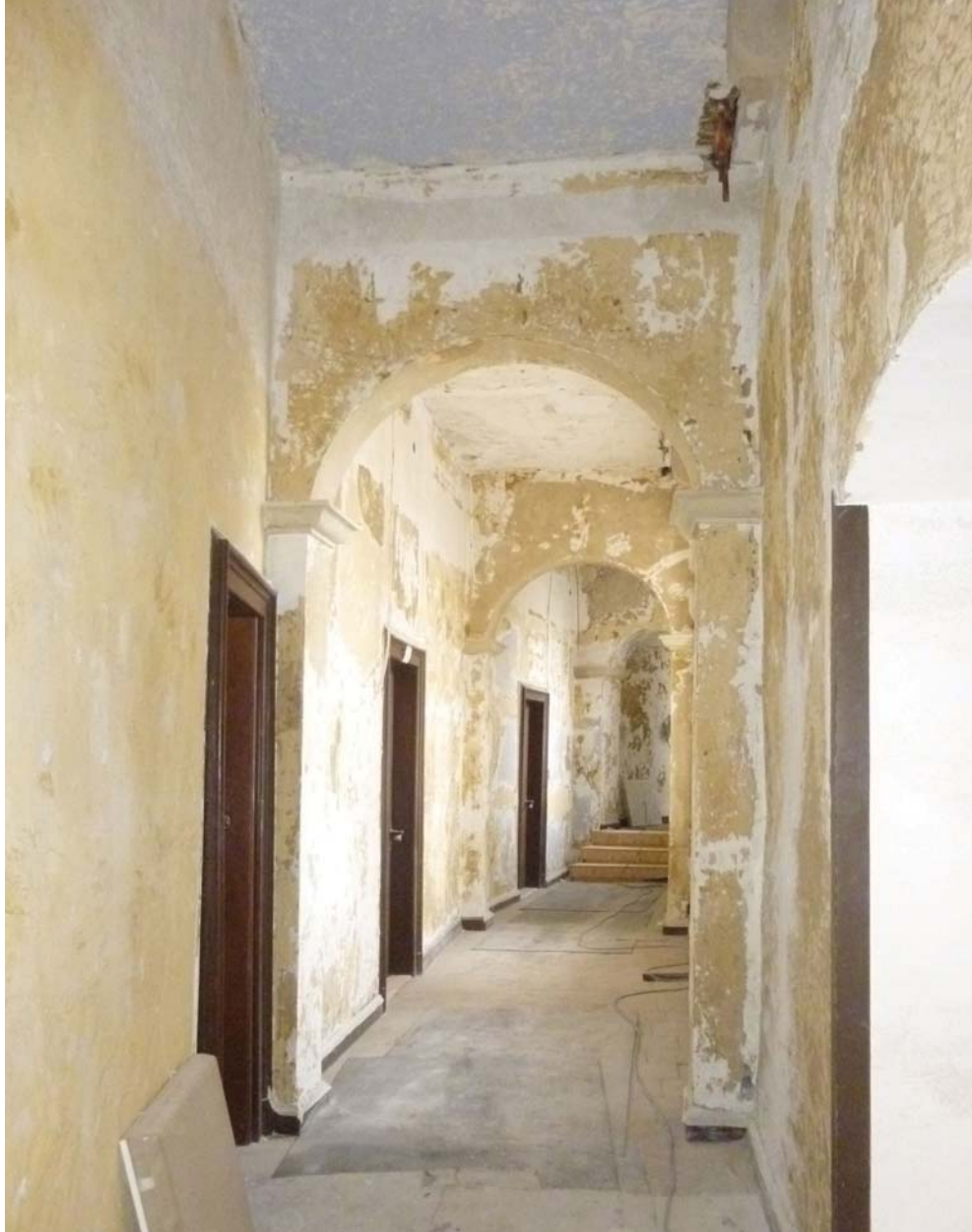
Erdgeschoss, Flur nach Entfernen der Oberflächenfassungen
