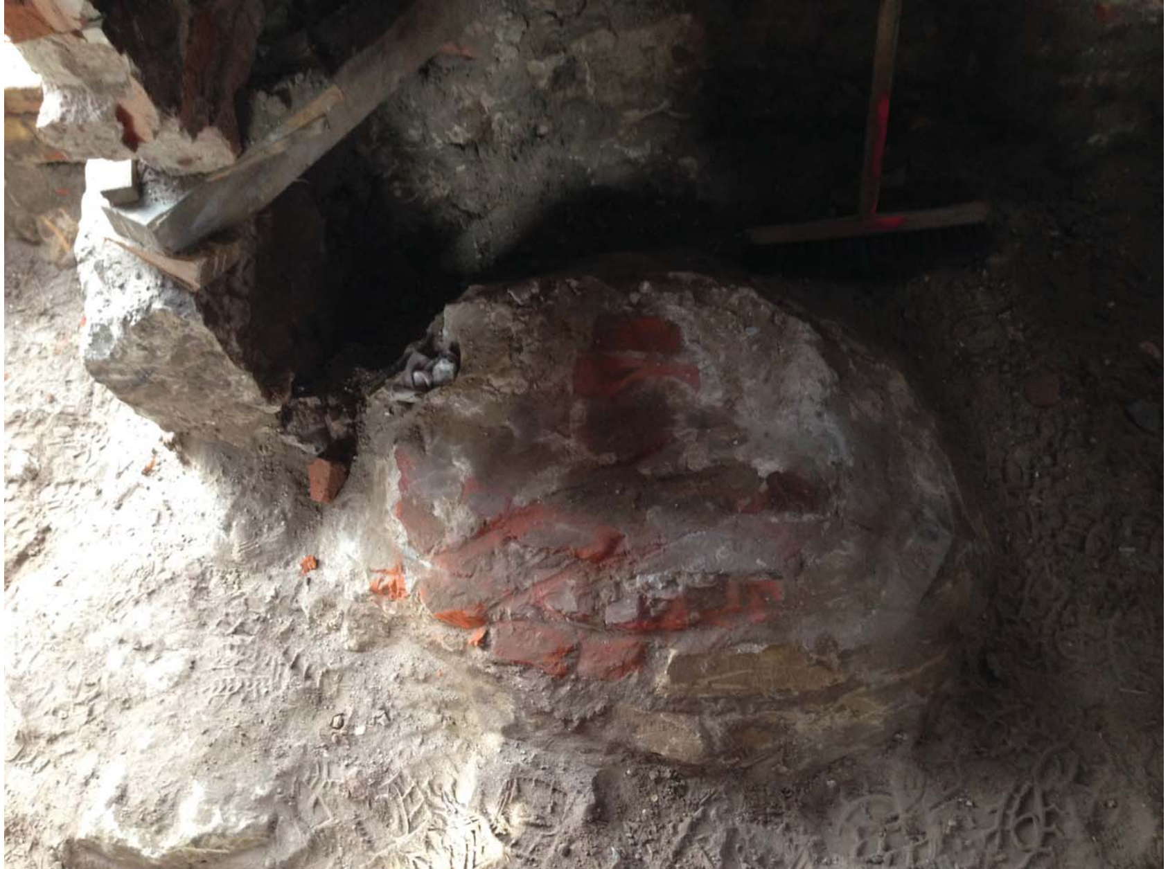
Wiederentdeckung Brunnen im Bestandsboden der ehemaligen Küche
