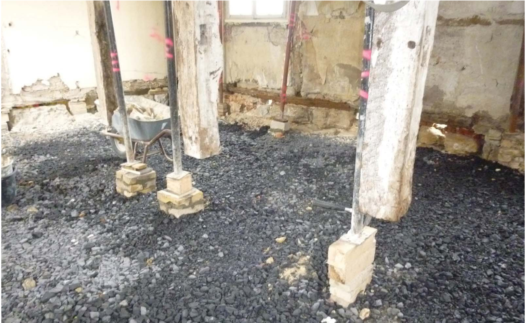
Museumsshop nach den Rückbauarbeiten
