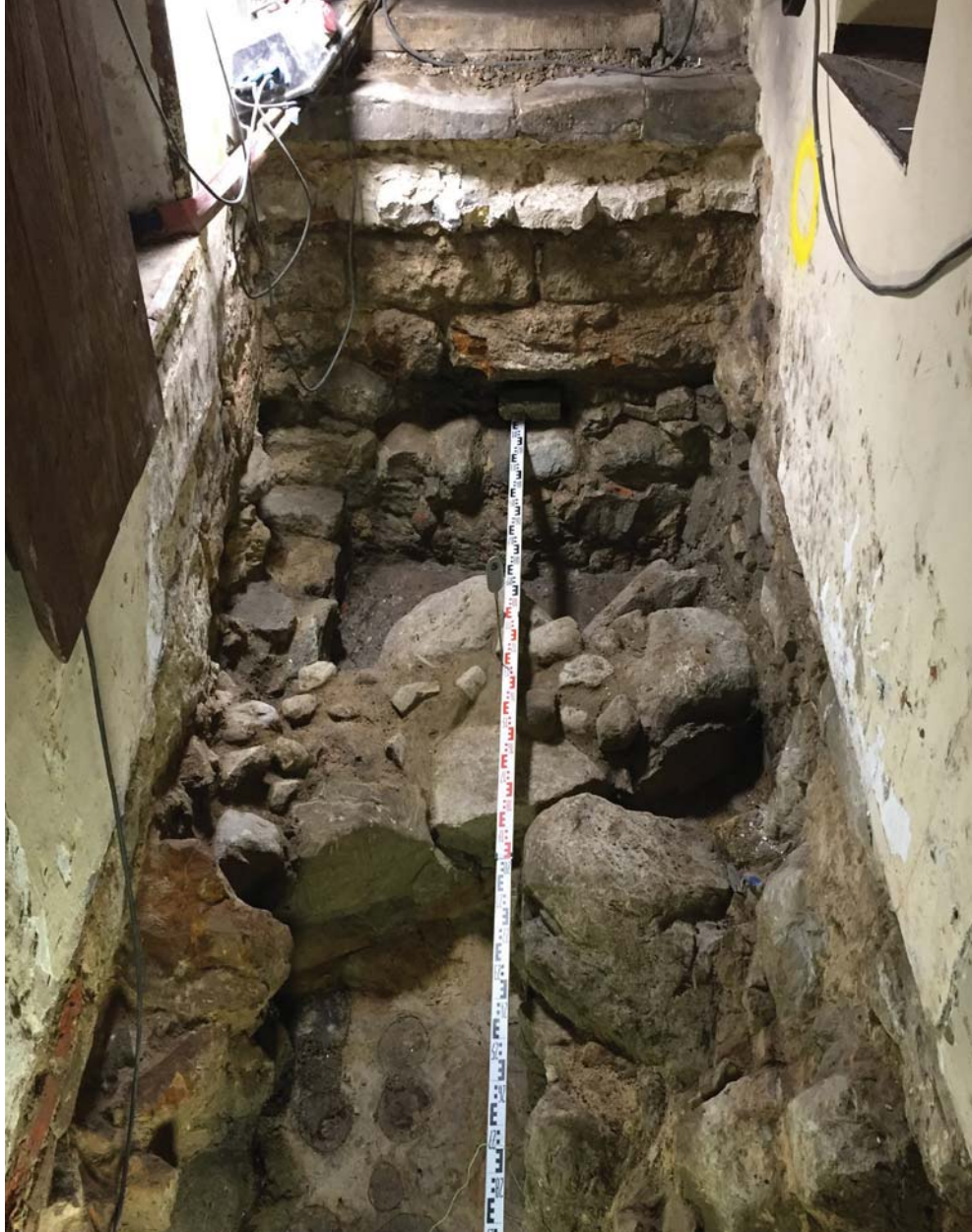
Sockelgeschoss, Fundamente eines älteren Bauwerks
