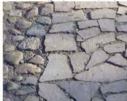
Verlegedetail Übergangsbereich zwischen Polygonalplatten und Kopfsteinpflaster
