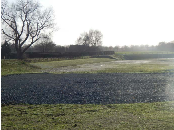
Foto 25: Regenrückhaltebecken im Südosten
