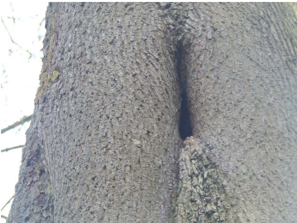
Foto 15: Spalte mit Faulung im Innern
