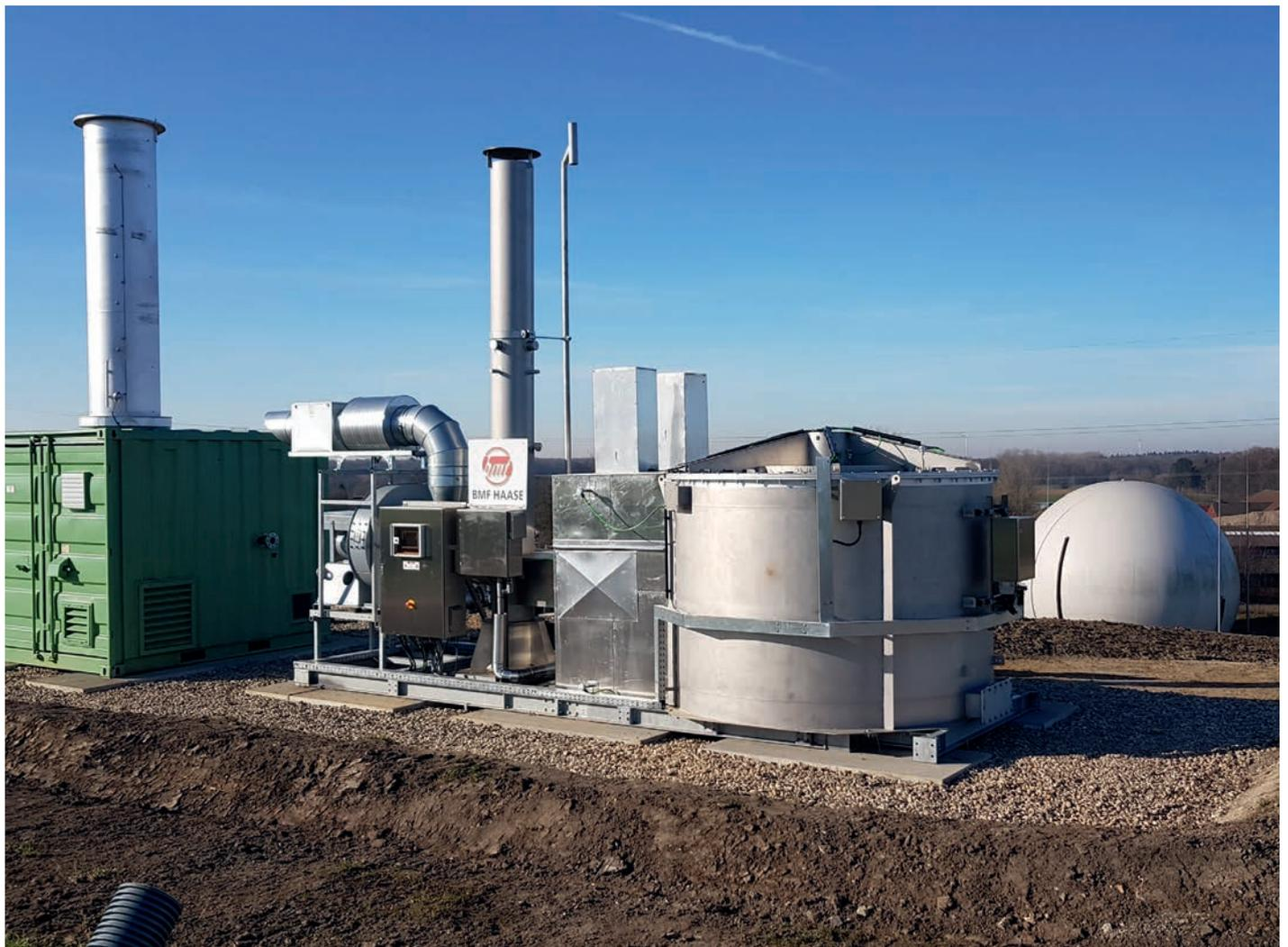
Schwachgasfackel (links, grün) und regenerative thermische Oxidation (RTO, rechts)
