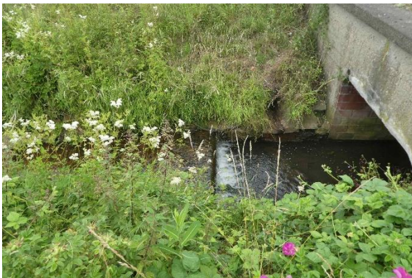
Foto 21: kleiner Sohlabsturz vor der Straßenquerung
