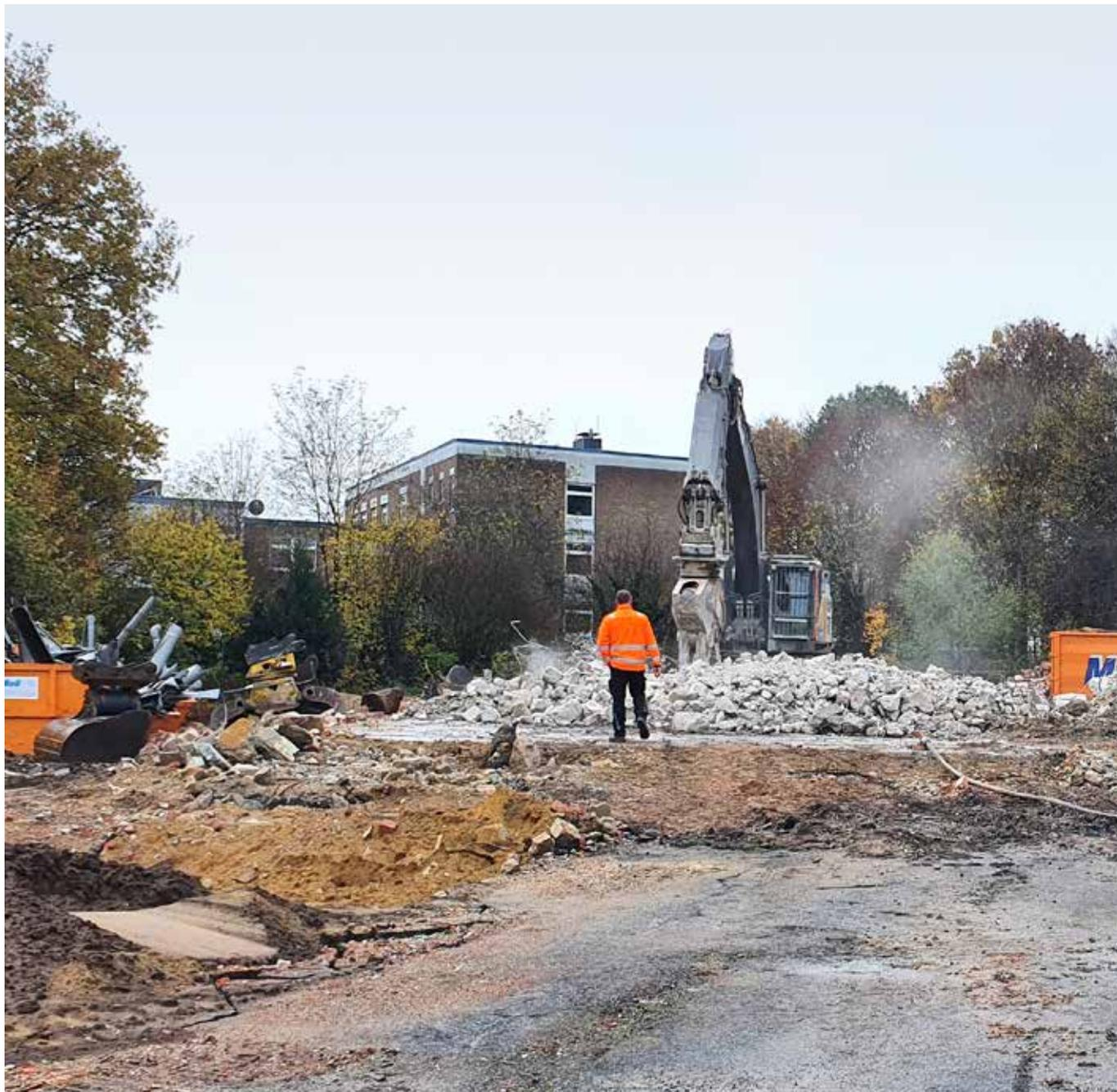
Am 04.10.2022 war es soweit. Das beauftragte Unternehmen konnte im ersten Schritt mit der Baustelleneinrichtung beginnen. Im Laufe der zehn wöchigen Abbruchphase wurden so ca. 3.000 Tonnen Material mit ca. 120 LKW-Ladungen abgefahren.
