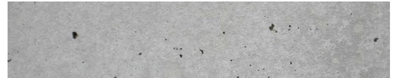
Sichtbeton mit geordnetem Schalbild Oberfläche: SB3, Schalplatte glatt
