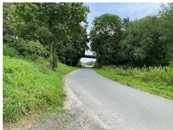
1.6 Foto: Blick auf die Brücke der Straßenüberführung
