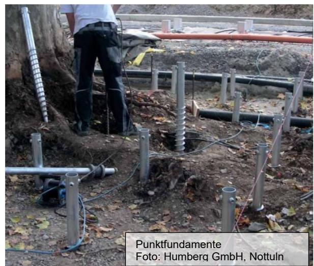
Auch bei der Installation der Wurzelbrücken ist im Arbeitsbereich mit Bodenverdichtungen während der Baumaßnahme zu rechnen (siehe Fotos Seite zuvor). Diese wären durch eine intensive Bodenbelüftung nach Abschluss der Baumaßnahme aufzulockern.
