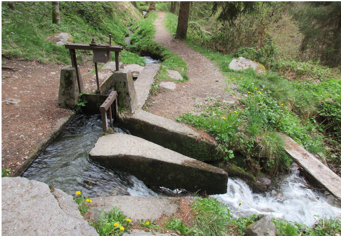
Abb. 7: Feinststeuerung der Zu- und Abflüsse unweit der Ausleitung mit ungesteuerter und gesteuerter Entlastung vor dem abschließenden Zulaufwehr
