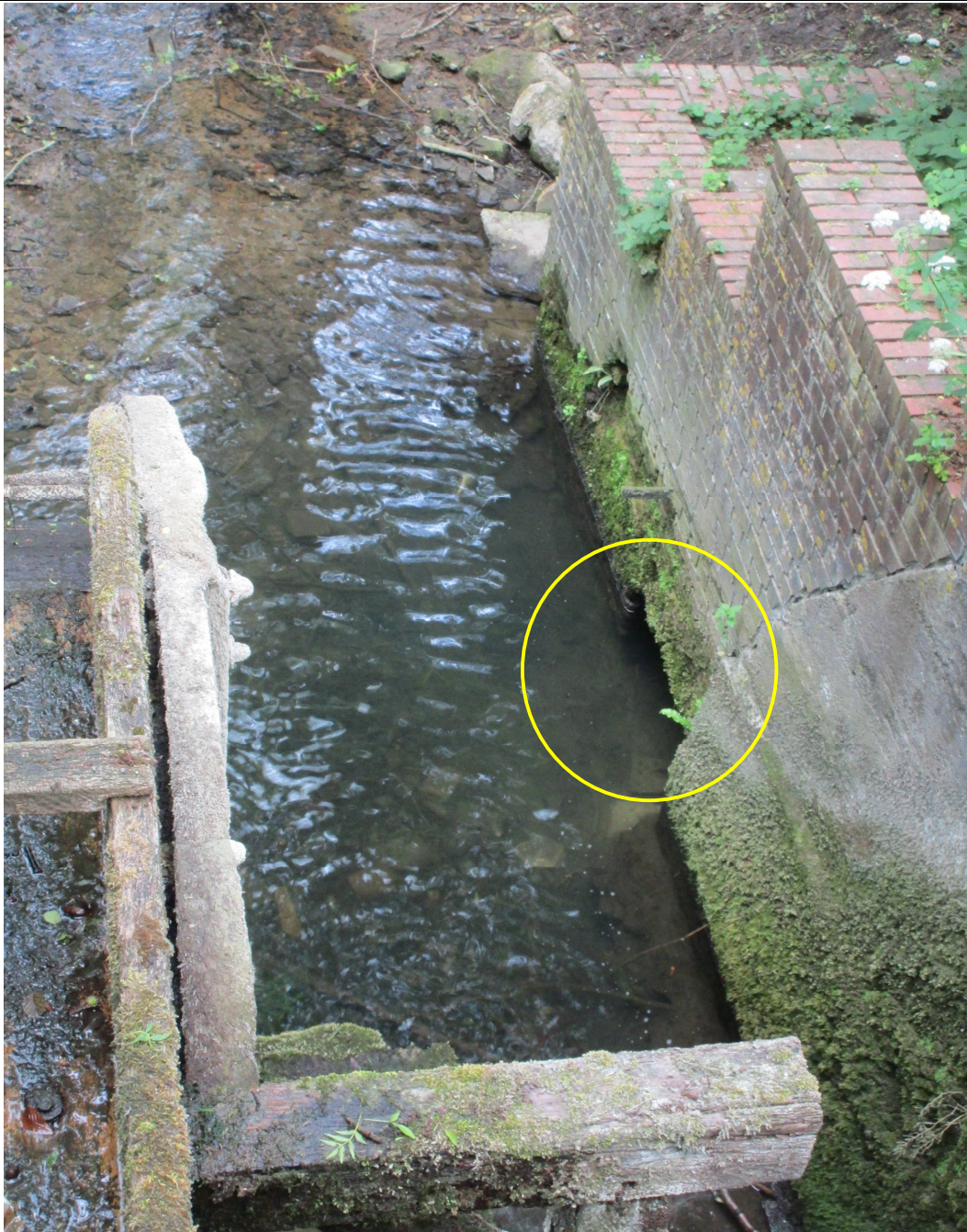
Abb. 13: Auslass des früheren Notüberlaufs
