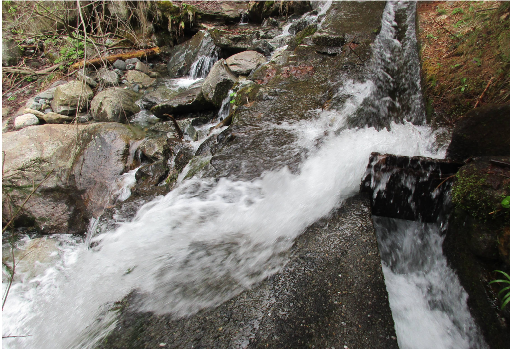
Abb. 6: Grundsätzliche Zulaufbegrenzung an der Ausleitung eines Waals
