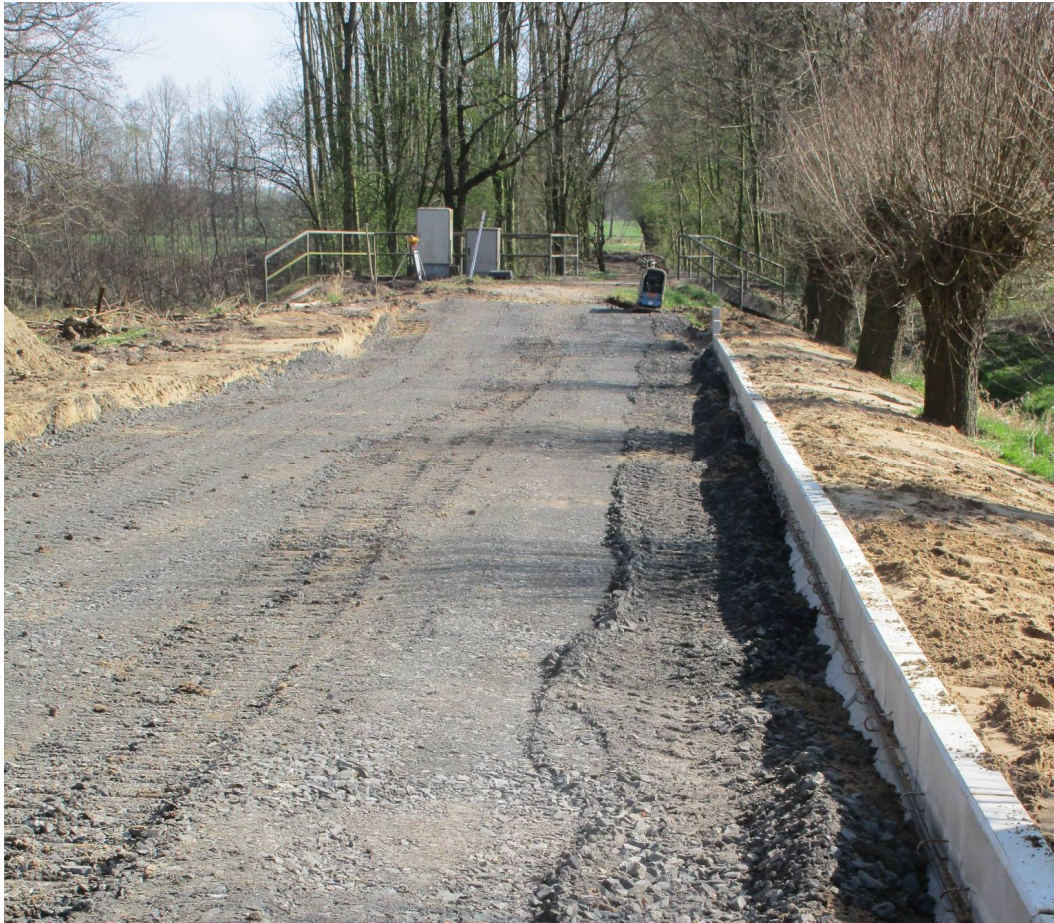
Abb. 15: Entlastungskonzept am RRB/HRB Korbeck am Varlarer Mühlenbach, links der Aufstau, mittig das Planum des Wags, der als Überlauf umgebaut wird und rechts die Kante, um rückschreitende Erosion zu verhindern
