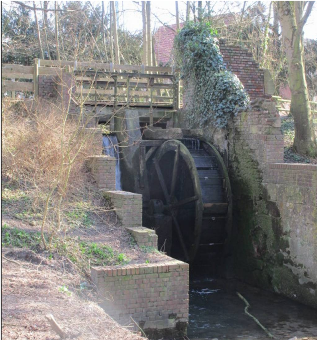
Abb. 20: Eingegriffen wird in dieses Mühlenbauwerk, einerseits durch Ertüchtigung der Stauklappen, andererseits links neben dem Brückengeländer durch eine kleine Aussichtsplattform, die dann aber den Zugang zur Berkel erschwert, siehe unten links der Trampelpfad, der sich hier gebildet hat
