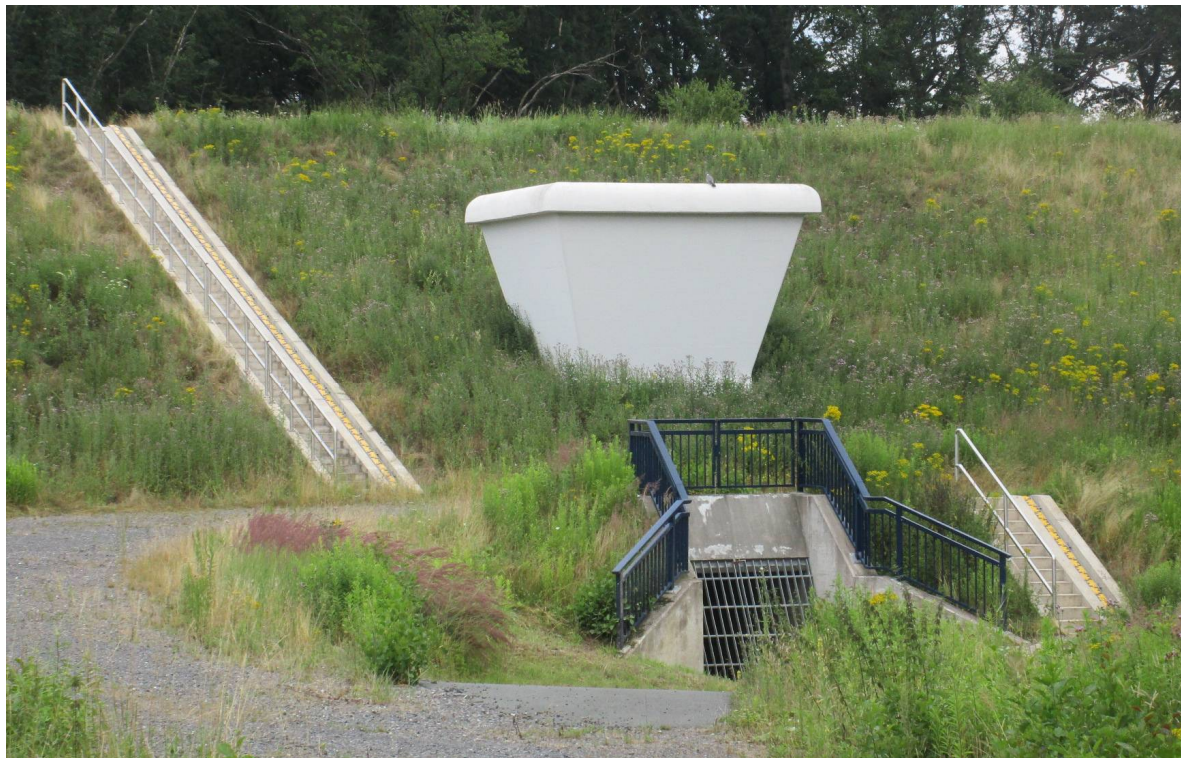
Abb. 11: Ungeregelter, erosionsgeschützter Überlauf, hier am HRB Lünerner Bach
