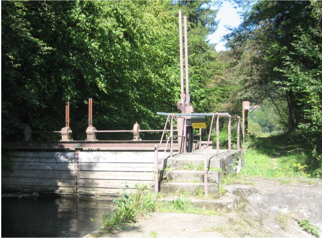
Abb. 8: Typisches Eingangwehr an einem Mühlengraben, hier an der Sieg bei Freusburg
