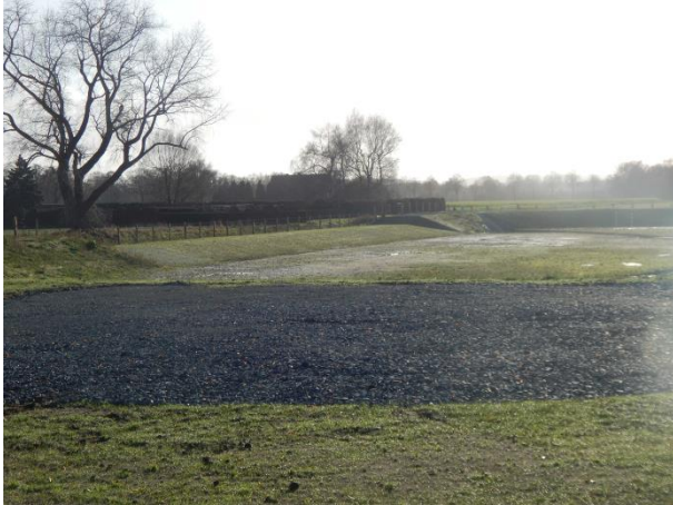
Foto 25: Regenrückhaltebecken im Südosten
