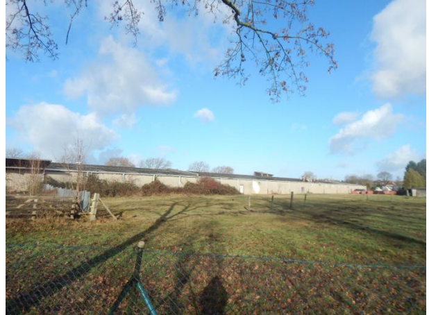
Foto 20: Gebäudekomplex im Nordwesten
