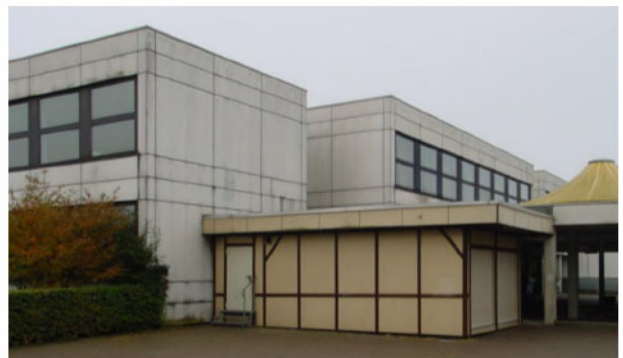
Erweiterung und Sanierung des Berufskollegs WuV in Ahaus
